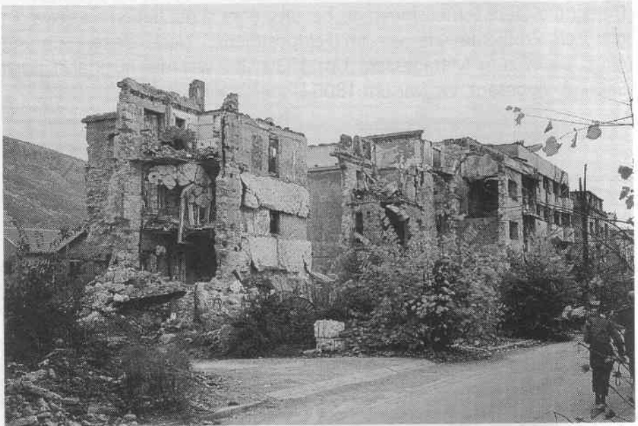
Total zerstörte Häuser in Mostar
